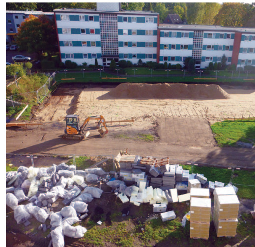
Norderstedt vor Baubeginn
