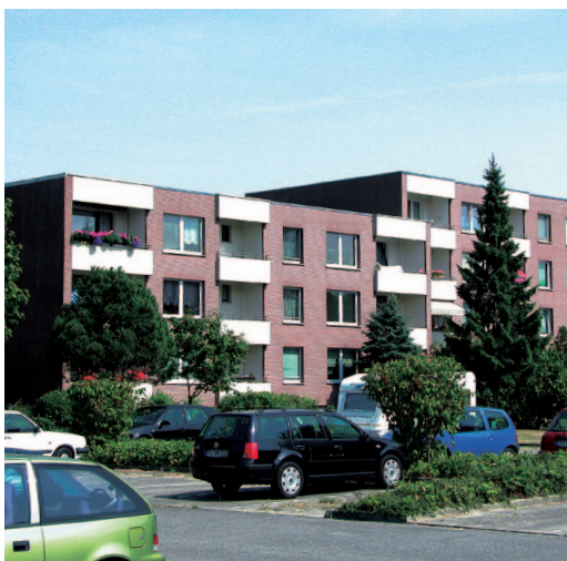
Wilhelmstraße vor der Modernisierung
