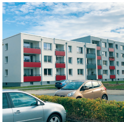
Wilhelmstraße nach der Modernisierung
